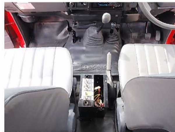
センターコンソール周囲 (A Pモニター配線断線により自動揚水不能)
